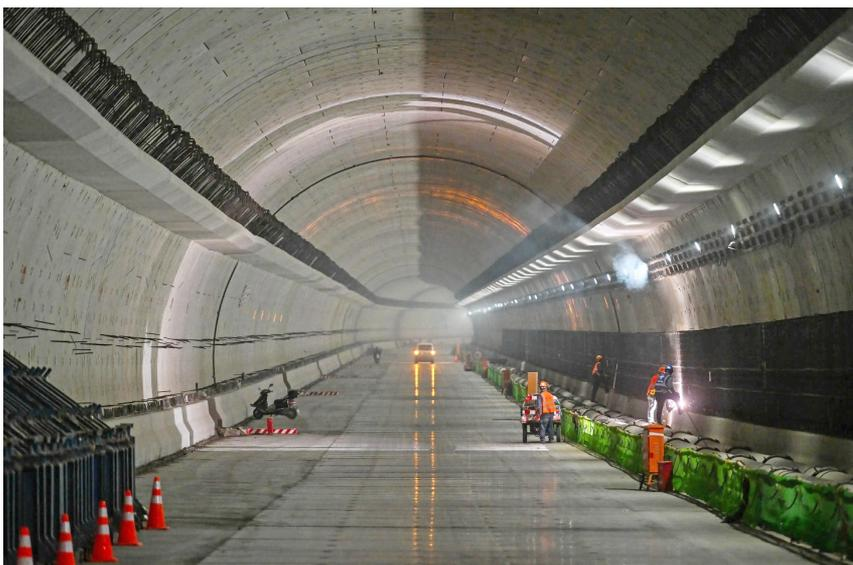
江阴靖江长江隧道北起江苏靖江新公路，南至江阴芙蓉大道，全长11.825公里，其中隧道全长6445米，盾构段长4900多米，开挖断面直径16.09米，项目计划于2025年建成。图为3月29日，工人在江阴靖江长江隧道内作业。
