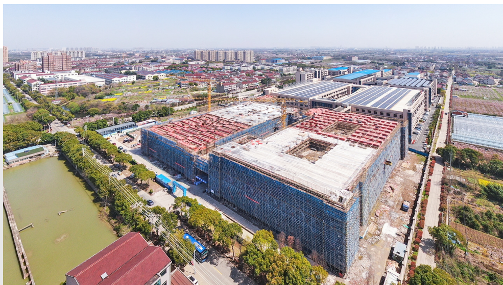
位于洛阳镇的市重大项目——洛凯新能源及智能电网用新型电力装备项目，目前正在加快主体建设中，预计2025年竣工。项目总投资超3亿元，新增中压车间装配环网柜柔性产线、五轴五联动数控铣车复合加工中心、AGV智能运输车等设备78台(套)，达产后将形成年产智能配电设施2万台(套)的生产能力。图为项目航拍。徐晶玮 摄
