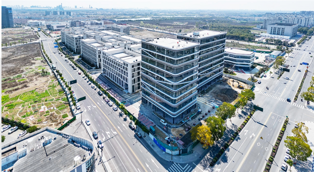
位于常州经开区遥观镇的联东U谷·宋剑湖创新智慧港作为中吴大道片区重要的产业载体，目前已竣工投用。该项目占地面积151亩，共建设38栋厂房，可满足企业生产、研发、办公等多种需求，将围绕新一代信息技术、智能制造、新材料等新兴产业招引企业，厂房容积率将达到2.0以上。图为项目航拍。徐晶玮 摄
