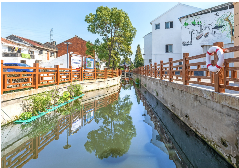
近年来，洛阳镇虞桥村改善农村人居环境，以小微水体整治提升行动为契机，先后投入100多万元，实施生活污水接管、河道清淤等一系列水岸同治工程建设，打造了“河畅、水清、堤固、岸绿、景美”的靓丽名片。图为虞桥村小微水体优秀片区。 钱垒 摄
