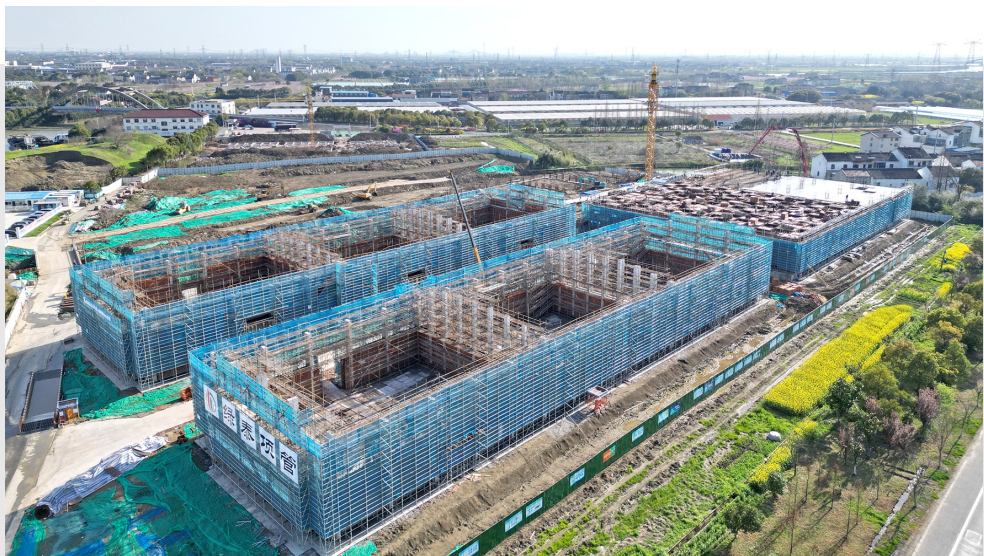
在建的武进粮食和物资应急储备库二期项目，用地36868.3平方米，规划总建筑面积31488.94平方米，将打造4.85万吨现代化粮食仓库以及15089.46平方米的综合物资储备库，用于成品大米及应急物资储备，并同步建设道路、水电相关配套设施。图为项目航拍。 钱垒 徐芊卉 摄
