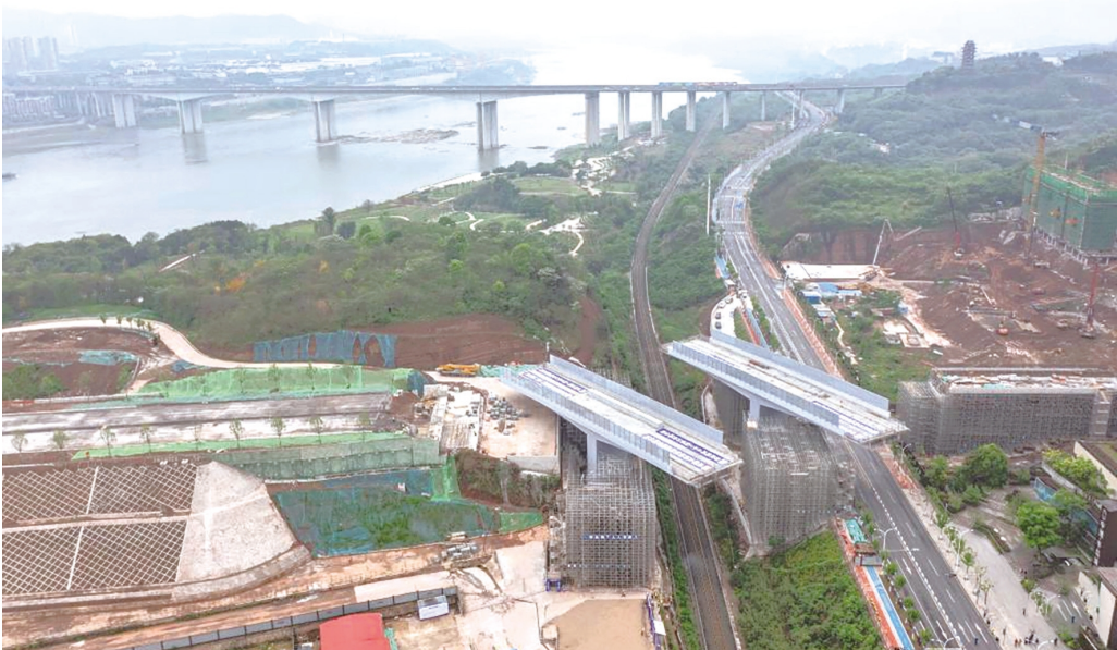
4月10日,在重庆市大渡口区钓鱼嘴半岛,上跨成渝铁路总重1.4万余吨的双幅转体桥历时110分钟实现精准转体对接施工。上跨成渝铁路的双幅转体桥为两座长90米、宽16.75米的T形刚构桥,单桥重量7000余吨,在液压牵引系统的带动下同步转动,与主桥精准对接。图为上跨成渝铁路的双幅转体桥在转体(无人机照片)。
