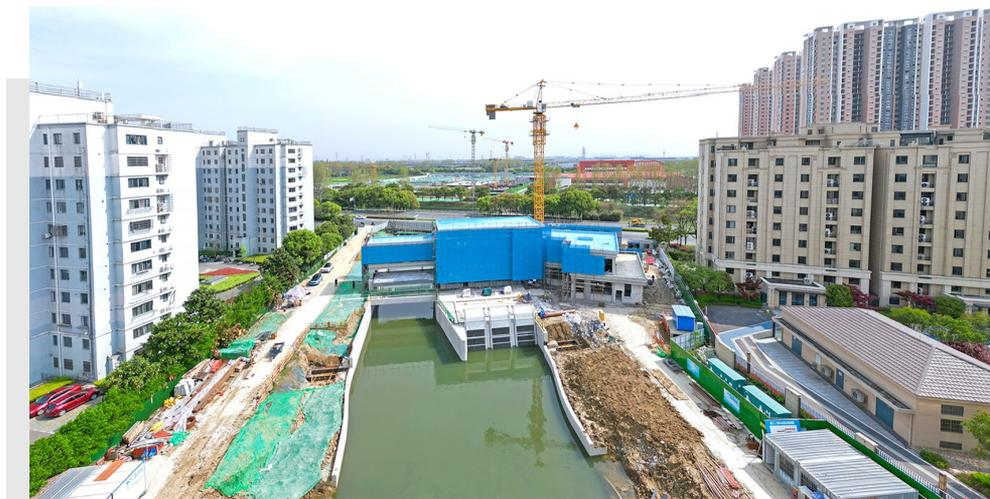
湖塘河南枢纽工程总投资6330.87万元,主要建设单孔净宽12米升卧式平面钢闸门节制闸,3台套潜水贯流泵,排涝15立方米/秒、引水10立方米/秒的双向泵站,内外河进出水池、清污机桥等。目前,已完成水下部分与主厂房施工,正在进行管理用房施工和设备调试,预计5月初投入使用。图为项目航拍。 陆新钱 摄
