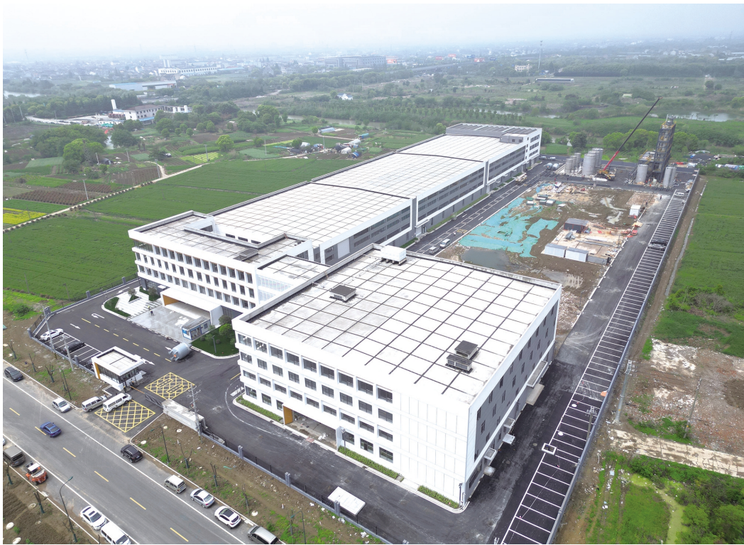
位于常州西太湖科技产业园的省重大项目——江苏先诺新材料科技有限公司高性能聚酰亚胺纤维新建项目,总投资5亿元,占地50亩。目前一期主体建筑已完工,预计今年投入使用。二期已开工,全部达产后将形成年产700吨的生产能力,同时具备下游产品开发及工程化能力。图为项目航拍。 陆新 钱垒摄
