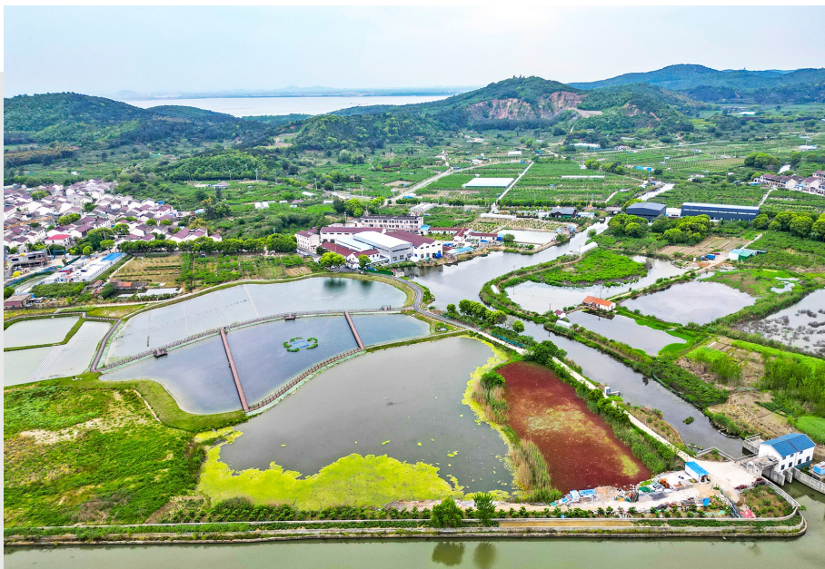
常州雅浦港生态缓冲区建设示范工程(一期工程)项目位于雪堰镇,实施农村生活污水治理、支浜规范化整治、种植业排污口规范化整治、支浜生态缓冲区建设四大类重点工程,从污染减排和生态扩容两手发力,将有效解决雅浦港片区的生活污水,恢复河道水体自净功能,达到“河畅、水清、岸绿、景美”的效果。图为项目航拍。徐晶玮 摄
