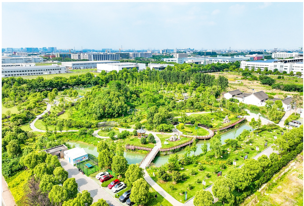
结合美丽乡村建设,南夏墅街道胜西村小微水体整治工程共投入资金150余万元,实施污水管网铺设、清淤疏浚、岸坡整治、河岸景观建设等,打造了“河畅、水清、堤固、岸绿、景美”靓丽名片。图为项目航拍。
