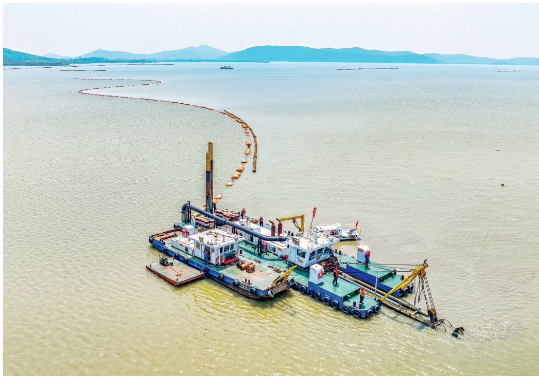
2024年度武进区太湖清淤二期工程于4月中旬开始出泥,目前已实现稳定出泥,累计出泥4万立方米,预计9月下旬全部完成。图为清淤现场航拍。 陆新 钱垒摄
