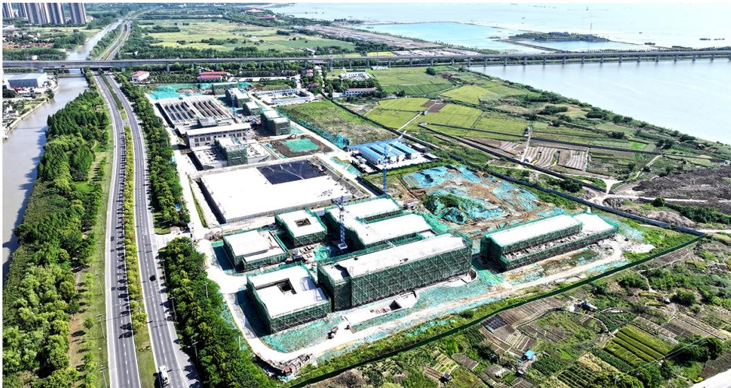
连日来，在湖滨水厂工程项目施工现场，工人们在保证高标准、高质量的前提下全力冲刺节点目标。截至目前，净水处理设施、排泥水处理设施、生产辅助设施及办公设施等主体土建已完成超70%；清水池、炭滤池、砂滤池等均在试水过程中；机修车间、臭氧车间等已完成墙体粉刷。据悉，湖滨水厂规划总建筑面积约2.3万平方米，其中一期项目供水规模达20万立方米/日，今年计划完成投资2.5亿元左右。
