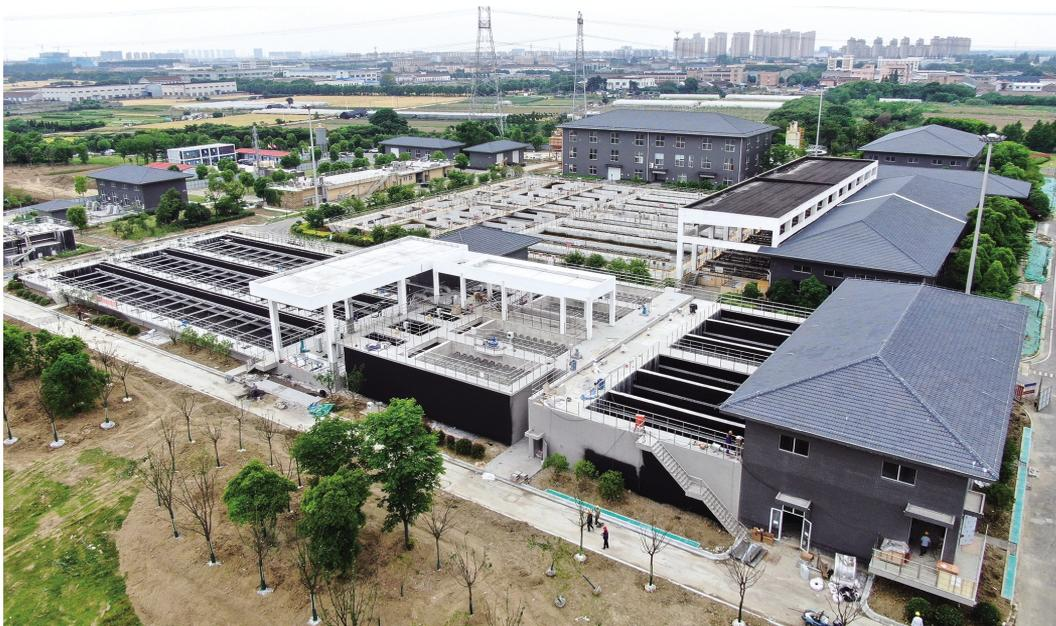
省重大项目——滨湖污水处理厂二期项目总投资约2.56亿元,采用多级AO生化池+高效沉淀池+深床滤池工艺。目前,主体建筑和厂内工艺管道施工已全部完成,正在进行部分设备安装调试,现已完成总工程量的75%,预计年内试运行。图为项目航拍。 陆新 钱垒摄
