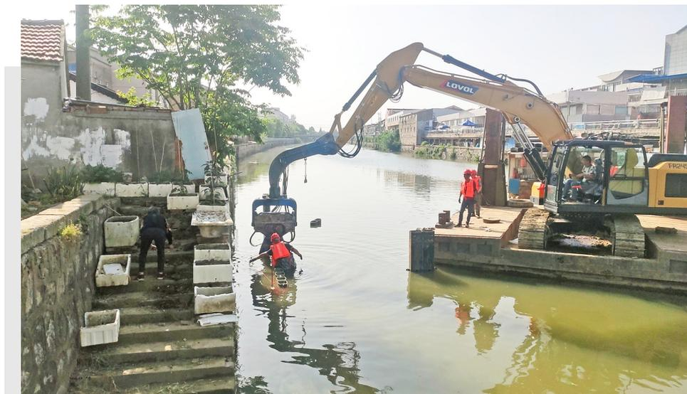
滄里河西起长荡湖、东至太湖，流经金坛区和武进区，全长 19.5 千米，属跨县重要河道，主要功能为行洪、治涝、供水及航运。日前，滄里河治理工程 1 标段进行试桩，对照方案对试桩工艺进行验证并取得相关参数。图为试桩现场。 史莲寅 摄
