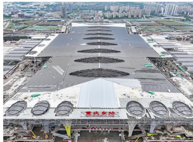
5月28日，西部地区最大高铁枢纽站——重庆东站钢结构屋顶正式完工，标志着重庆东站站房全面进入装饰装修施工阶段。重庆东站站房及配套综合交通枢纽工程建成后，将引入渝湘高铁、渝万高铁、渝贵高铁、渝昆高铁等多条线路，成为以高铁为核心，集轨道交通、公交、商业与办公等为一体的综合性交通枢纽。新华社发
