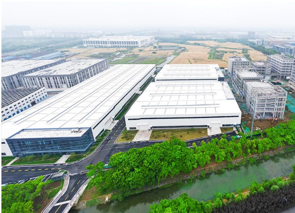
位于常州西太湖科技产业园的省重大项目——琥崧微纳米材料高端装备制造基地项目,总投资11亿元,用地110亩。一期3栋厂房已于2023年竣工,目前正在进行产线的安装与调试。二期6栋厂房正在进行外立面幕墙施工,计划8月竣工。达产后将实现年产智能分散及研磨设备500台,产线配套设备、模块及智能生产线10套的生产能力。图为项目航拍。
