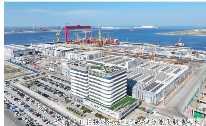
6月17日拍摄的海油工程天津智能化制造基地。
