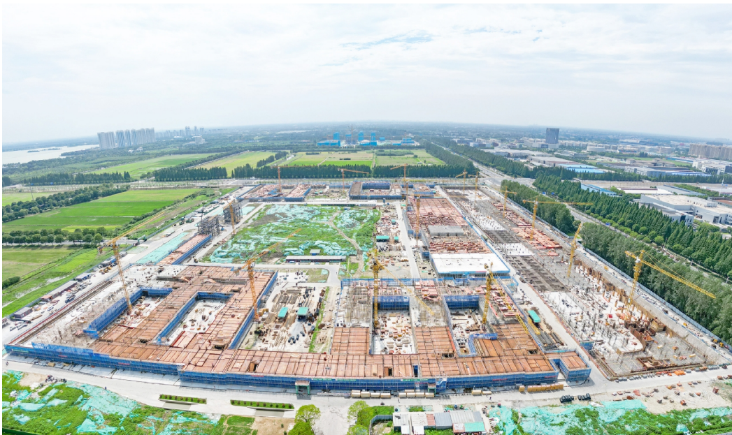
华东师范大学附属常州西太湖学校由武进区人民政府、华东师范大学、江苏致远教育发展有限公司合作创办，为一所定位国内一流、国际先进的全日制国际化K12学校。目前基本完成行政楼、教学楼、艺术楼的基础混凝土浇筑，项目总体进度达35%，预计明年上半年竣工落成，9月正式开学。图为项目航拍。 陆新 钱垒摄
