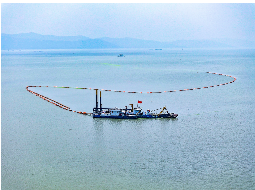
眼下,太湖正处于安全度夏攻坚期。我区持续推进太湖清淤工程,清淤船每天连续12小时作业,对竺山湖湖底进行清淤疏浚。图为清淤船正在工作。 陆新 徐晶玮 摄
