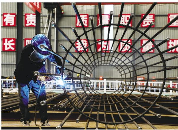
在花海大道一标钢筋集中加工配送中心内,项目部专门安装了水空调,为工人们防暑降温。图为电焊工正在进行桥梁桩基结构的焊接。
