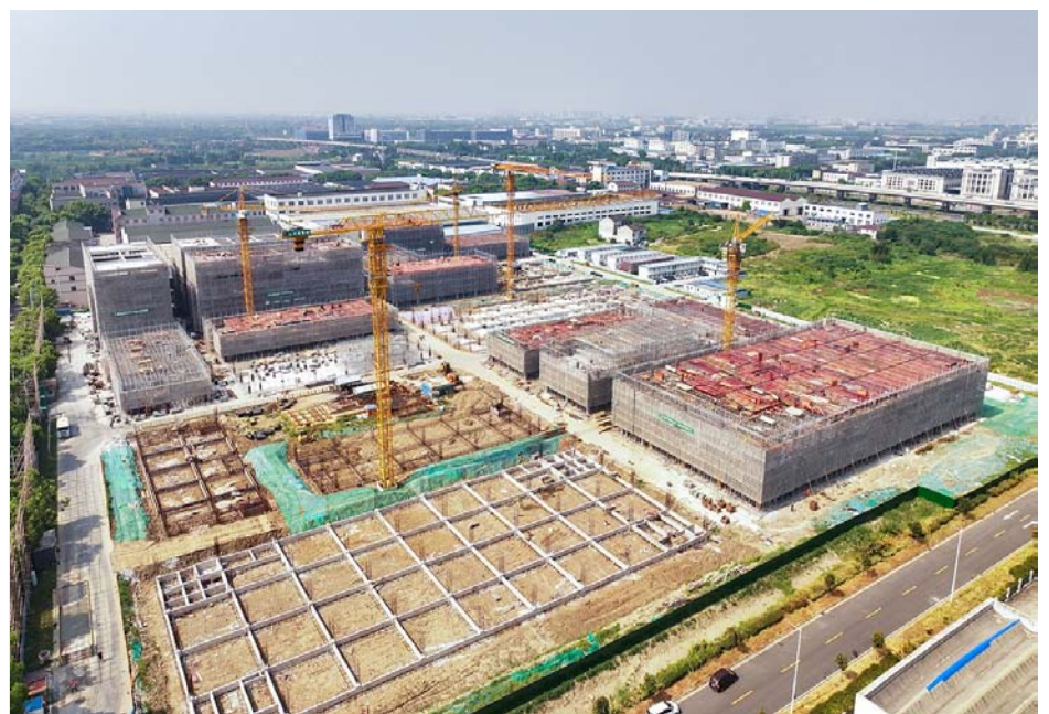
礼嘉振新产业园一期项目建筑总面积 10.8 万平方米,建设 20 栋厂房,目前完成项目总进度 30%,建成后将重点引进专精特新、高新技术企业,促进礼嘉镇工业经济高质量发展。
