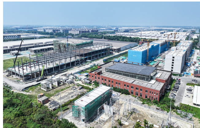
位于武进国家高新区的区重点项目——10吉瓦TOPCON电池厂房及配套设施建设项目总投资14.3亿元,占地约220亩,建筑面积约11.8万平方米,拟建成10吉瓦TOPCON高性能电池产线。目前已完成建筑主体施工,预计明年一季度投产。图为项目航拍。 钱垒 摄
