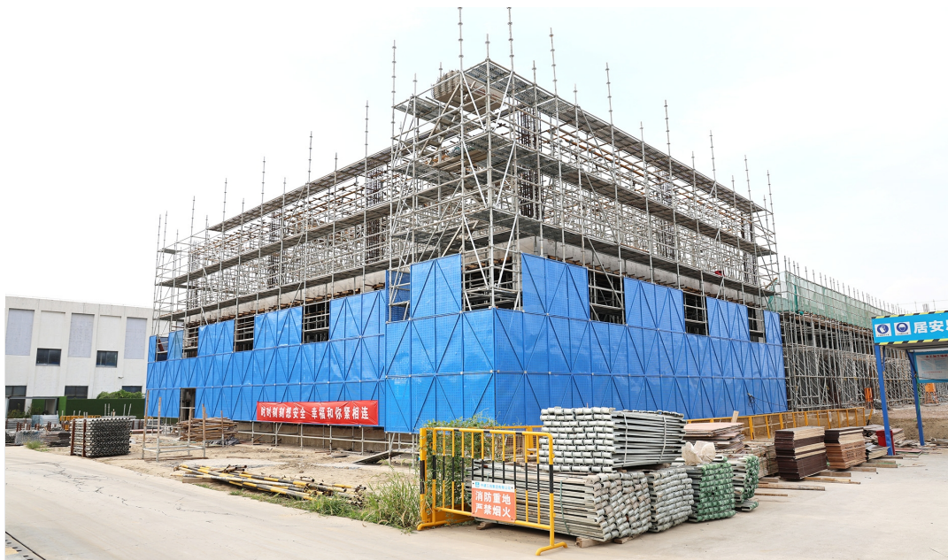
目前,常州国际机场改扩建工程正有序推进。这是机场建站以来实施的第四次改扩建,主要建设内容为扩建航站楼3.6万平方米,新建货运库1.9万平方米、综合停车楼2.37万平方米等,计划于2026年6月全面建成投用。图为已完成基础及待运区钢结构安装施工的货运站区域。 施劭婧 摄
