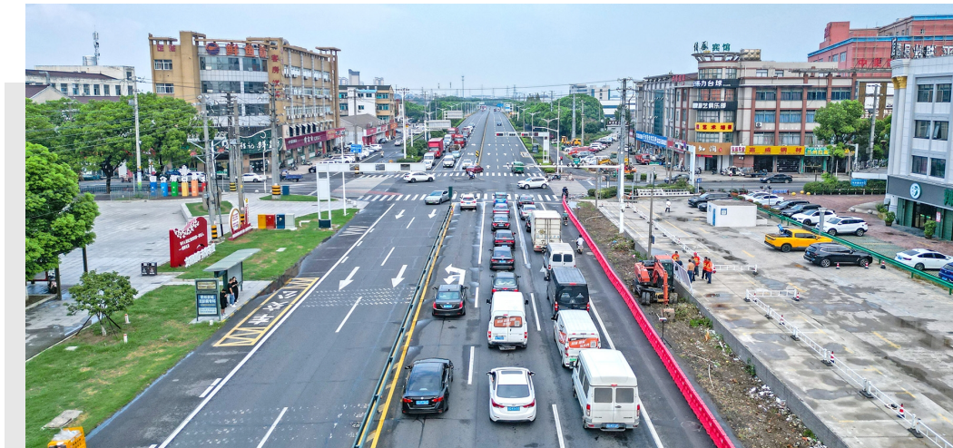
为改善X204武进大道沿线交通情况复杂、安全隐患日益凸显等问题,今年以来,区公路事业发展中心启动X204武进大道改造项目,目前正在加快施工。项目涵盖沿线开口归并、平面交叉口渠化、路域环境整治等内容,预计11月竣工。图为施工现场。 万峥鸣 徐晶玮 摄
