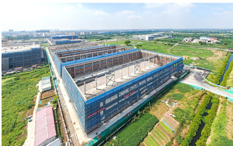
省重大项目——科恩新能源智能装备项目位于常州西太湖科技产业园,总投资10亿元,达产后新增年产锂电、钠电窑炉、锂电池回收全自动处理生产线以及其他新能源产业智能装备300套的生产能力。项目预计明年2月竣工,10月全面投产。徐晶玮 摄
