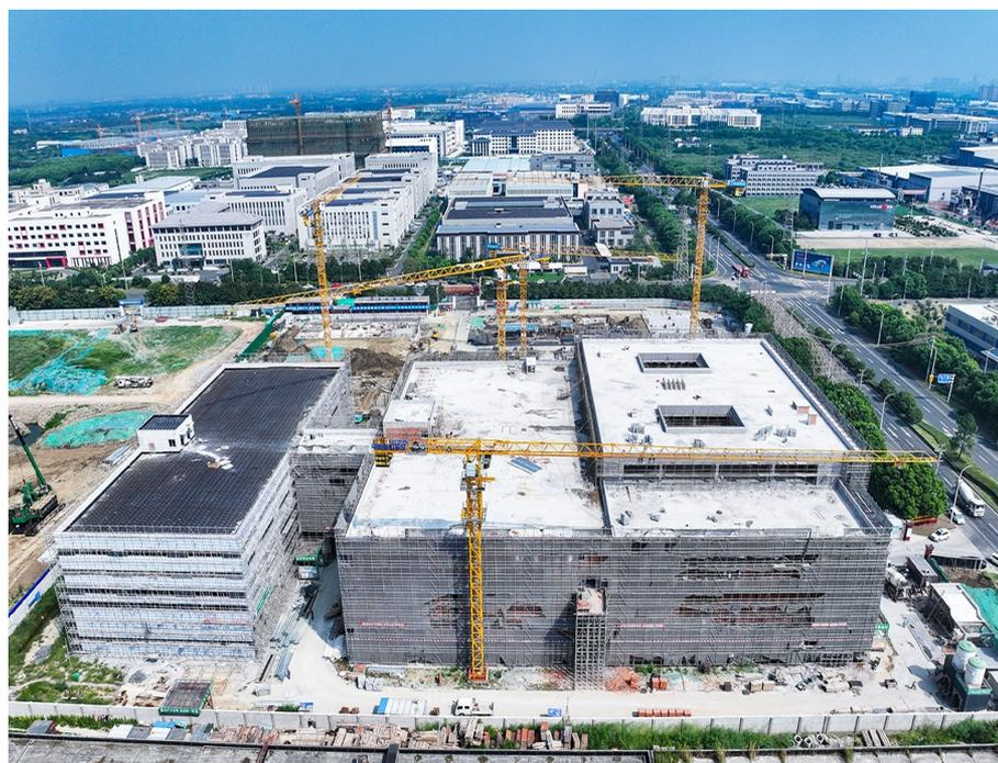
位于常州西太湖科技产业园的市重大项目——常州迪瑞尔医用新材料有限公司新建项目,总投资3亿元,规划建设无菌生产车间、研发中心、实验大楼等约2.6万平方米,预计明年3月竣工投产。目前项目主体建筑已封顶,正在进行外立面施工,达产后预计年产8000吨医用膜和300万套生物制药及细胞培养用一次性工艺耗材。
