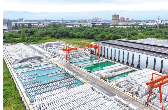
9月30日,由中铁十一局承建的成渝中线高铁青白江管片厂完成1000环管片生产,并配备了充足的管片存储空间。据了解,成渝中线高铁是我国“八纵八横”高铁网沿江通道的重要组成部分,正线全长292公里,设计时速350公里。图为9月30日拍摄的成渝中线高铁青白江管片厂(无人机照片)。新华社发
