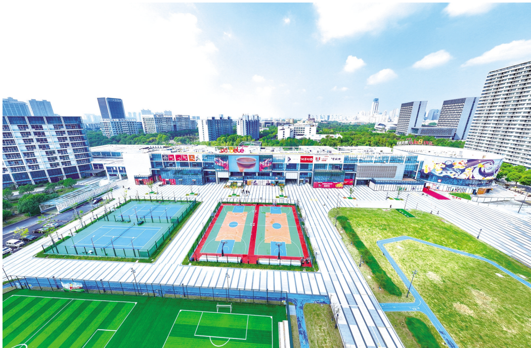
目前,位于常州科教城的常州510碧乐时光项目招商率已超过九成,预计11月底开业。该项目商业面积近3万平方米,将打造常州首创场景式活力中心,集美食、商务娱乐等多元业态为一体,并建设了篮球场、足球场、网球场和滑板公园等,满足青年人才的一站式需求。图为常州510碧乐时光航拍。 陆新 钱垒摄
