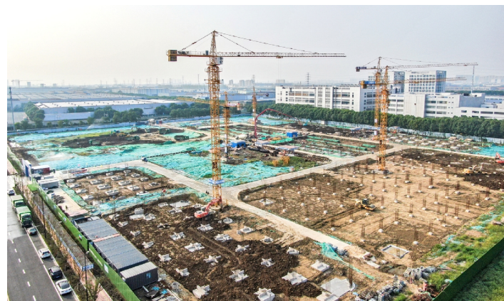
市重大项目龙城芯谷项目位于武进国家高新区,总规划面积443亩,一期项目占地面积100亩,规划建设面积13.3万平方米,涵盖展示交流中心、总部办公、研发中心、中试中心、科创孵化中心、产业化标杆等,目前项目一期正在加快土建中。图为项目航拍。徐晶玮 摄
