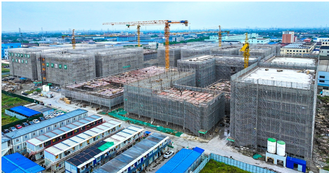
礼嘉振兴产业园一期项目建筑总面积10.8万平方米，建设20栋厂房，目前4栋厂房已封顶，预计明年5月竣工投用。项目建成后，将重点引进“专精特新”、高新技术企业，促进礼嘉工业经济高质量发展。图为项目航拍。 钱全 摄
