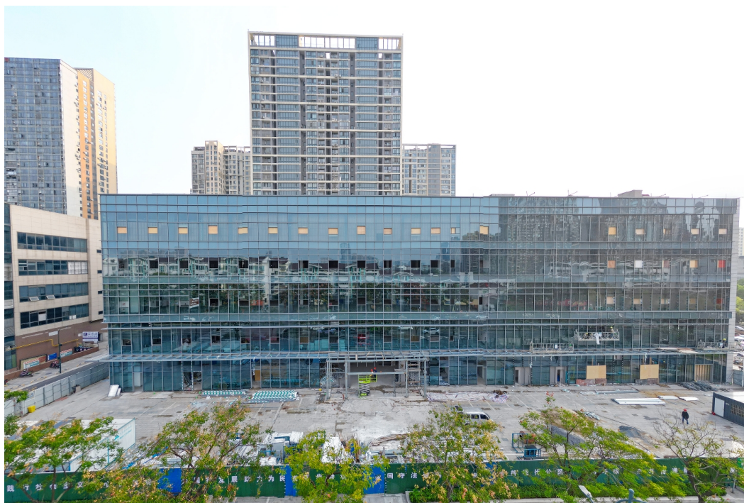
湖塘镇便民服务中心将迁址至湾里中心,东临花园街,西面武直路,坐落于茂业国际旁。新的便民服务中心一楼为办事大厅,二楼为社会事业及企业服务相关业务部门。目前,便民服务中心外立面装修已完成,正在进行内部装修。图为施工现场航拍。 钱垒摄
