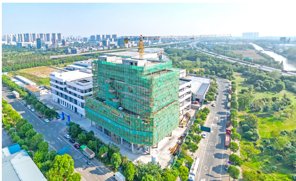
区重点项目——正彦数码智造融合创新中心项目位于武进绿建区，总用地面积24.28亩，总投资3亿元，主要建设标准化厂房、办公研发用楼等，全部达产后可形成年产数码打印罐4000万个的生产能力。目前该项目已封顶，一期项目预计年内竣工。图为建设现场。 徐晶玮 摄
