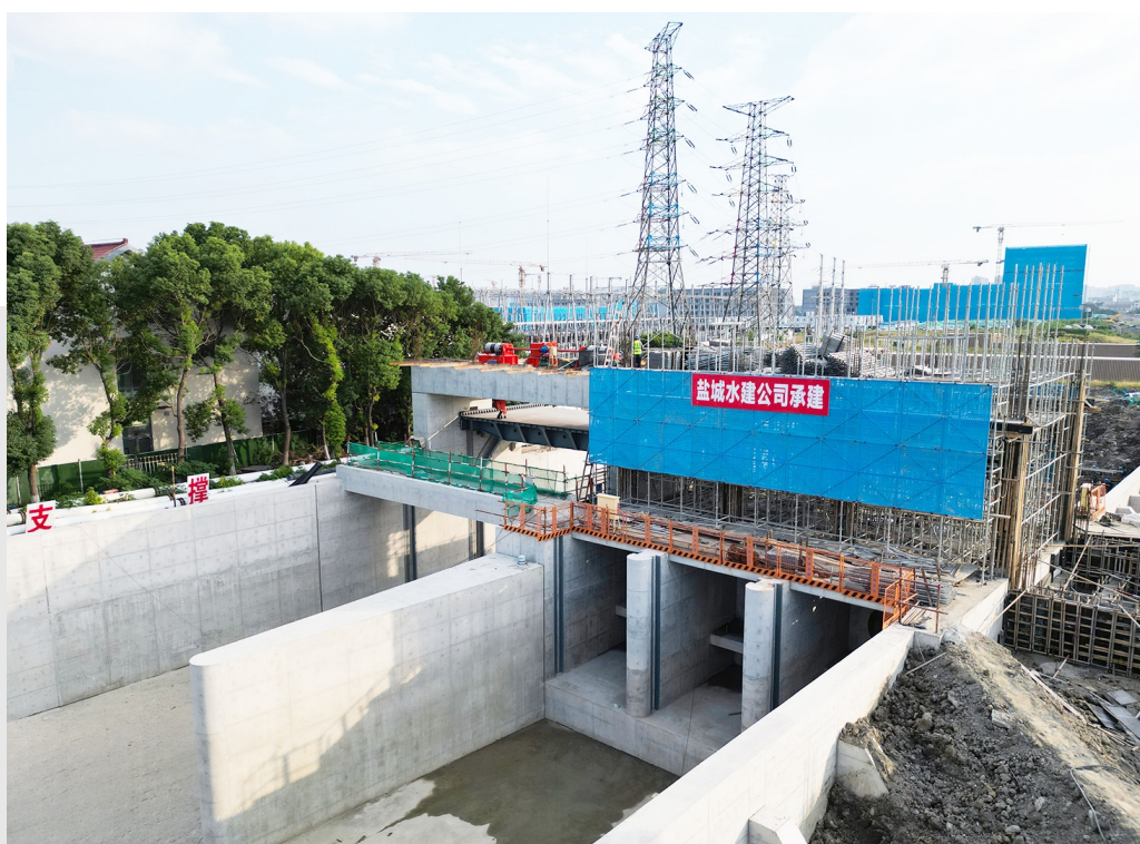
江苏理工学院武进绿建区协同创新园配套闸站建设工程——淹桥浜闸站工程,是区重点项目,总投资4500万元,由单孔净宽12米节制闸和9立方米/秒泵站组成,目前已完成闸门、机泵设备安装,正在进行管理用房施工。图为项目航拍。 钱奎 摄
