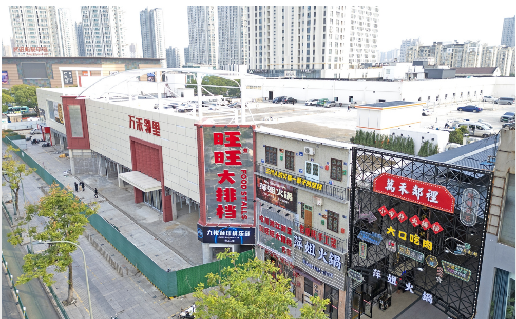
湖塘镇万禾邻里中心项目对原武进乐购进行改造,总建筑面积约3万平方米。项目以“品质零售、餐饮美食、儿童综合、社交生活服务”为四大核心打造新商圈,招商率达100%,目前处于内部装修阶段,预计月底投用。 钱奎摄
