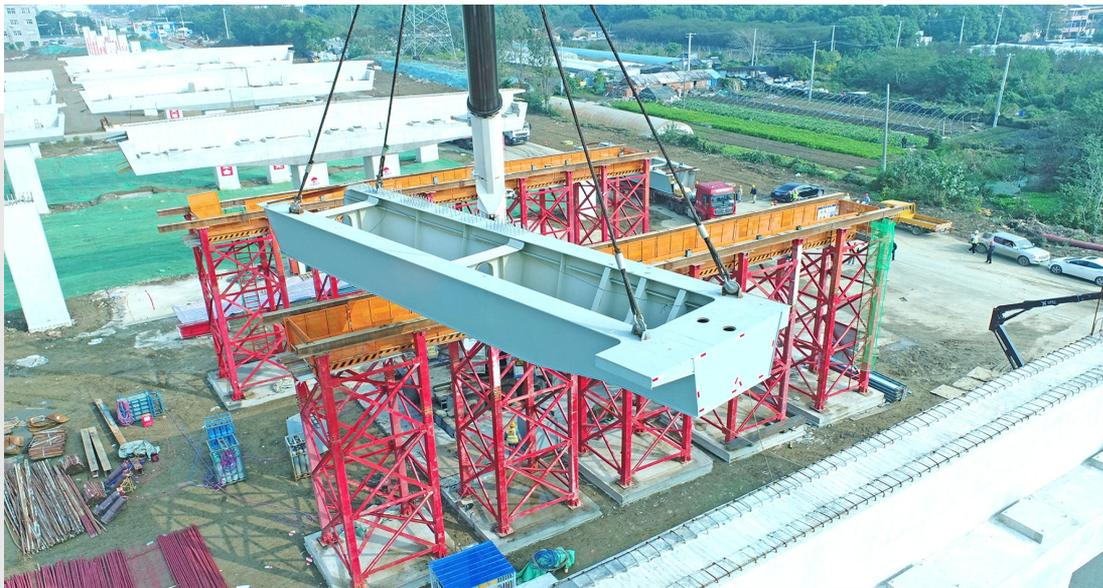
日前，由江苏恒基路桥股份有限公司承接的腾龙大道智慧快速路二期工程TLDD-SG4标项目完成首片钢混梁吊装作业，标志着腾龙大道项目建设进入新的关键时期。本次吊装为主线第38联45米钢混组合梁，分为5个独立箱室，每个箱室沿纵向划分为3个节段进行拼装，后续还将进行上部36块预制桥面板的安装，最终形成整体钢混组合体系。图为首片钢混梁吊装现场。
