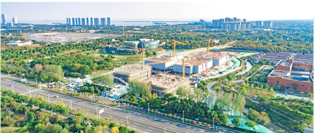
区重点项目长三角青年创新创业港二期位于一期东侧，占地约80亩，项目主体为具有科技感、未来感的复合型建筑，布局孵化生产、研发实验、共享办公、酒店公寓、生产性服务配套、生活性服务配套等功能。目前，项目土方工程、基坑支护工程均完成95%左右。 王子鹏 摄
