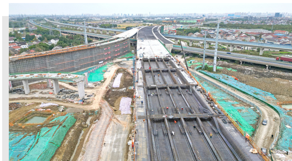
目前,G312快速路工程项目正加快推进现浇、预制盖梁架设等桥梁上部结构施工和路基填筑,预计2026年底竣工。项目建成后,与无锡西段快速化改造工程共同将常州、无锡两地的快速路环线实现无缝衔接。图为G312快速路工程项目航拍。徐晶玮 摄
