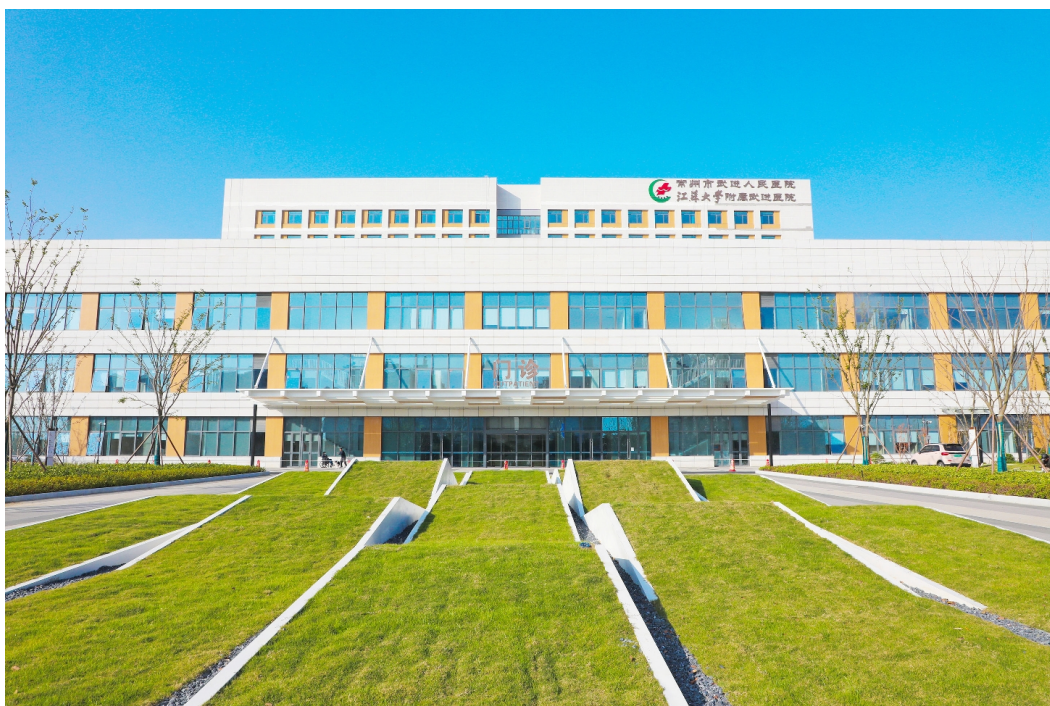
目前,武进人民医院南院二期项目已通过验收,部分科室正在陆续搬迁至新大楼,预计今年12月正式投用。该项目总建筑面积12万平方米,新增床位1000张。图为新建的门诊病房综合楼。徐芊卉摄
