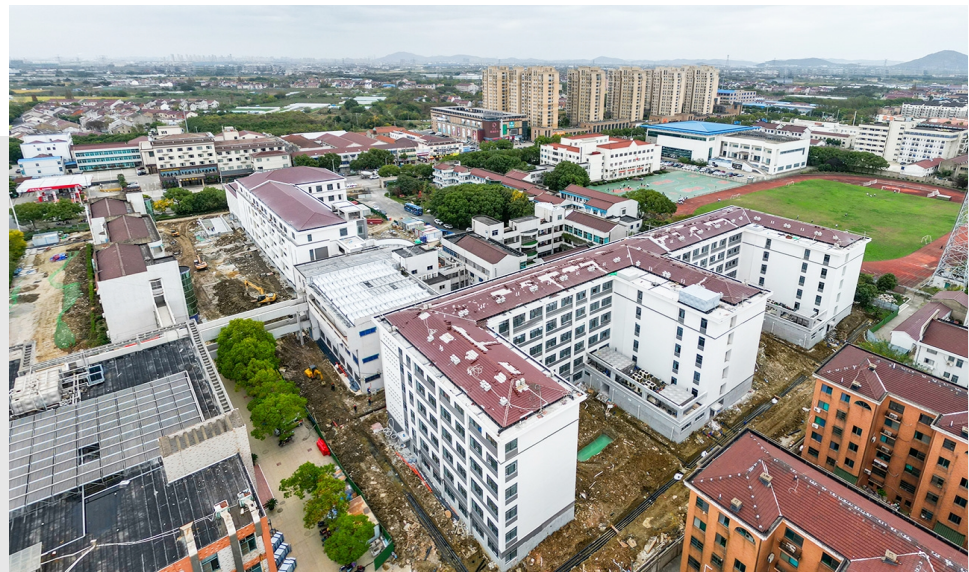
作为区民生实事项目的洛阳高中改扩建工程总投资1.6亿元，目前已完成主体施工，进入内外装饰阶段，预计2025年春季学期投用，建成后能容纳约2500名学生在校学习。图为项目航拍。徐晶玮 摄
