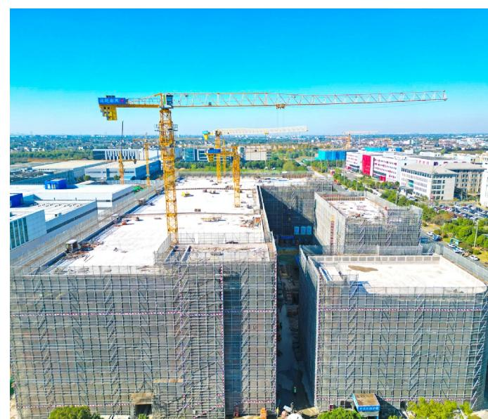
位于西太湖科技产业园的市重大项目——天华新能源检测设备生产及检测服务项目,于今年6月开工,用地28亩,规划建设生产、办公等建筑约4.1万平方米,拟购置及搬迁检测设备仪器200台(套)。目前主体已封顶,预计明年5月竣工,达产后将新增年检光伏组件900套的能力,预计实现年新增产值收入2亿元。图为项目航拍。徐芊卉 摄
