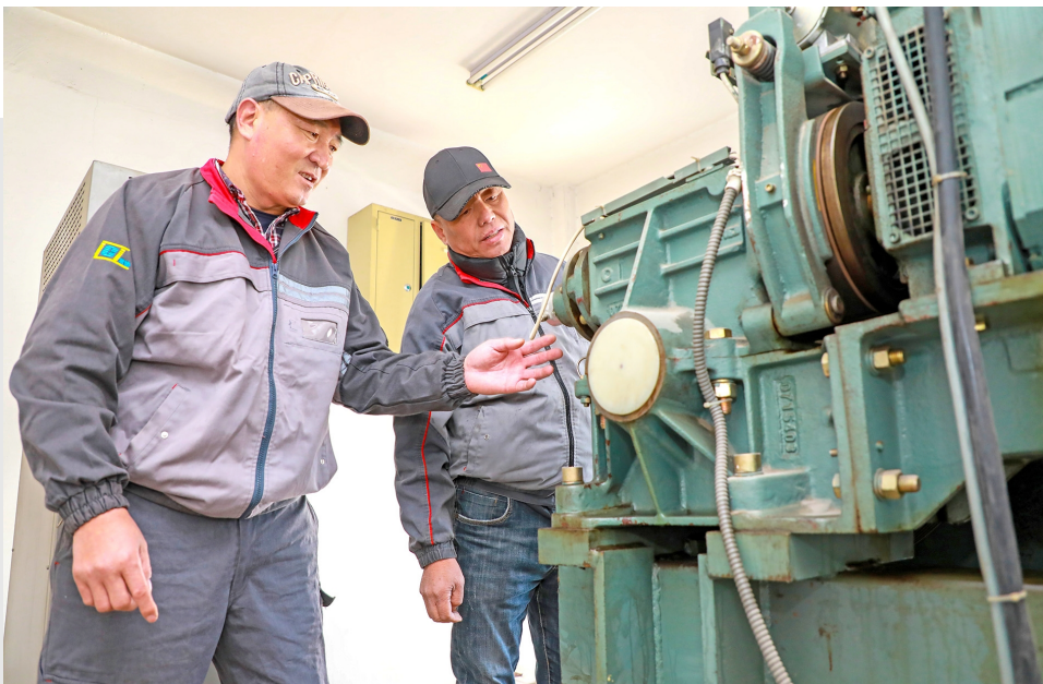
日前，湖塘镇针对辖区住宅小区、宾馆等人流量较大的重点区域开展老旧电梯安全检查行动，确保电梯运行安全，保障人民群众生命财产安全。图为工作人员在检查电梯运行情况。徐晶玮 摄
