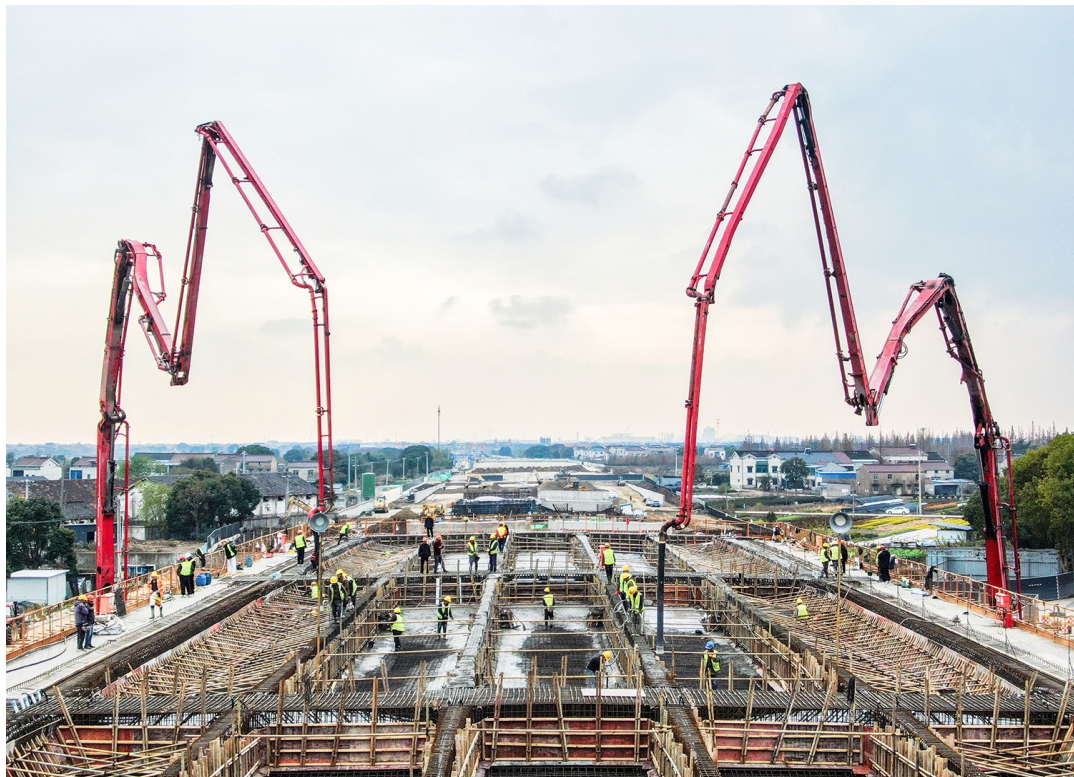
日前，花海大道(延政西路—湟村线)工程首件箱梁顺利浇筑完成，拉开了高架桥梁上部结构施工序幕。该工程是连接“两湖”水乡生态区与核心区的南北向快速通道，也是“两湖”创新区核心区45公里快速内环的重要组成部分。工程起于延政西路，顺接现状花海大道，往南下穿苏南沿江城际铁路后上跨沪武高速，终于湟村线，全长约9.9千米。图为工人正在加紧进行浇筑施工。
