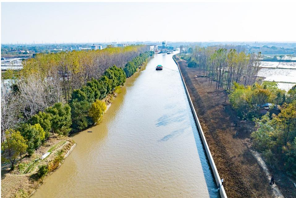
今年下半年,区港航中心按六级航道标准,在常宜线塘洋桥段新建护岸409.5米,现已全面竣工。常宜线航道为市干线航道,年通过船舶流量超3000万吨。水流常年冲刷堤岸,导致多处堤岸坍塌严重。新建护岸工程实现了南、北侧与护岸全线相接,保障了通行安全,增强了航道防汛抗洪能力。
