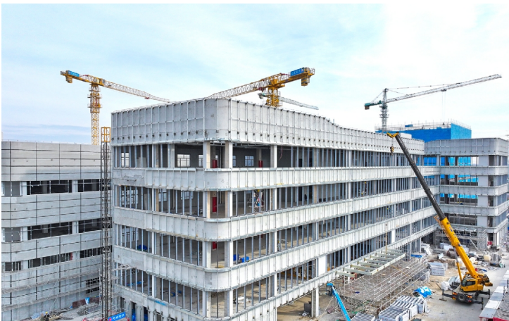
区重点项目——江苏君华特种高分子材料股份有限公司新厂区项目位于武进国家高新区,总投资3亿元,建筑面积约5.1万平方米。
