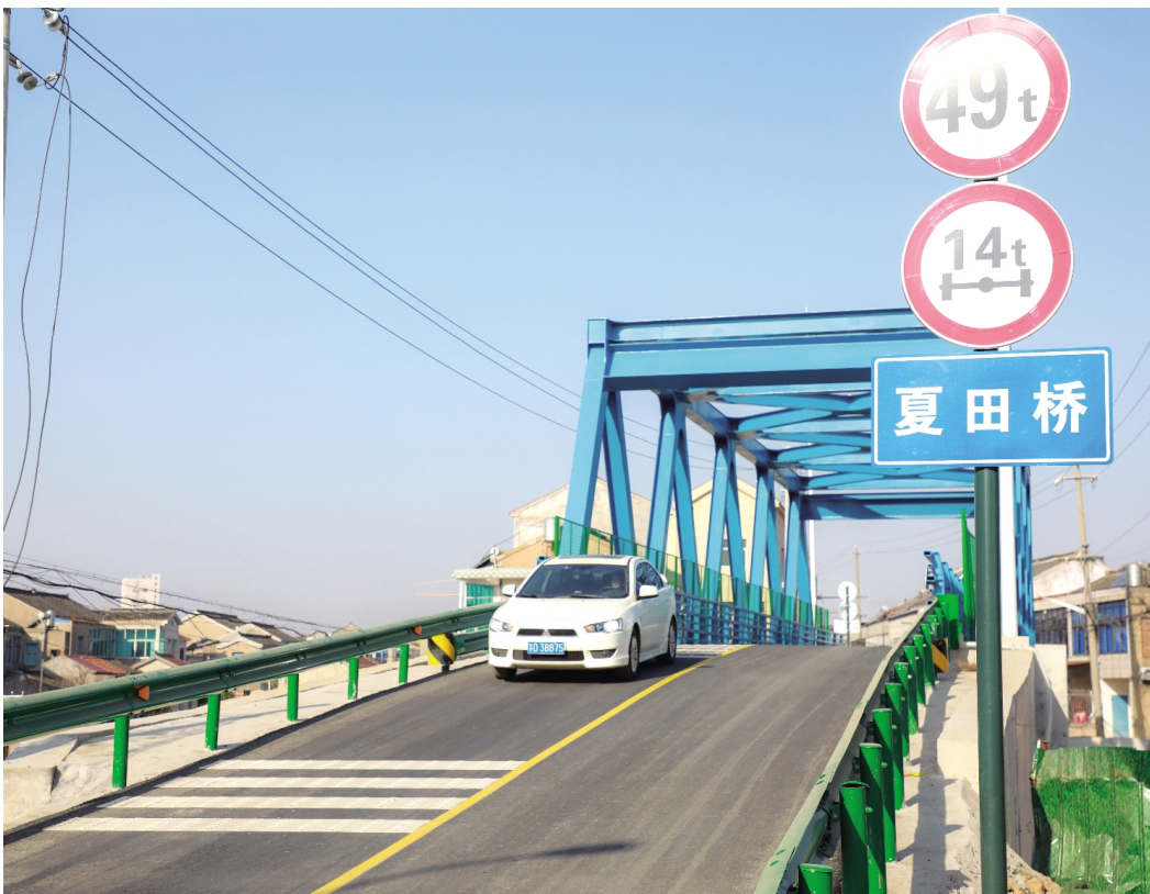
近年来, 我区始终把农桥建设作为民生实事工作的重点持续推进, 2024年共完成改造6座农村危桥, 村民日常出行条件大大改善。图为改造后的湟里镇夏田桥。 陆新 徐晶玮摄
