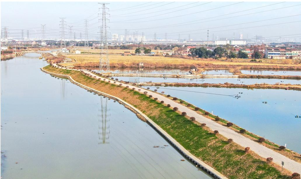
小留河圩堤加固工程位于洛阳镇，包括新建混凝土防护1222米、堤顶道路1200米，以及实施堤坡种植绿化9825平方米等。目前，该工程已完工并通过验收，将为洛阳人民群众的安全提供坚实保障。
