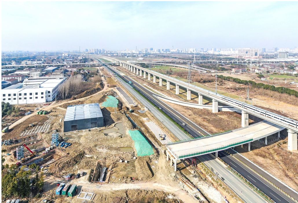
沪武高速公路太仓至常州段扩建工程武进段目前已全面开工,其中武进段全线沿既有沪武高速加宽扩建。项目东起北塘河,经沪蓉高速与沪武高速横林枢纽,跨沪宁城际铁路、京杭运河,穿312国道、青洋路,止于沪武高速常州南,全长约24.6公里。 陆新 徐晶玮 摄
