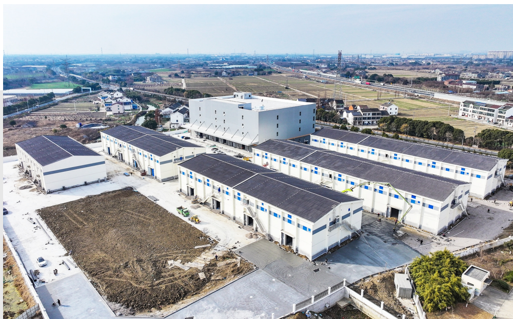
区重点项目——前黄粮食物流园(武进粮食和物资应急储备库)位于前黄镇,规划总建筑面积3.13万平方米,目前粮食仓库及综合物资库主体结构已竣工,园区成功接入电力系统,项目预计3月底竣工验收。 钱全 摄
