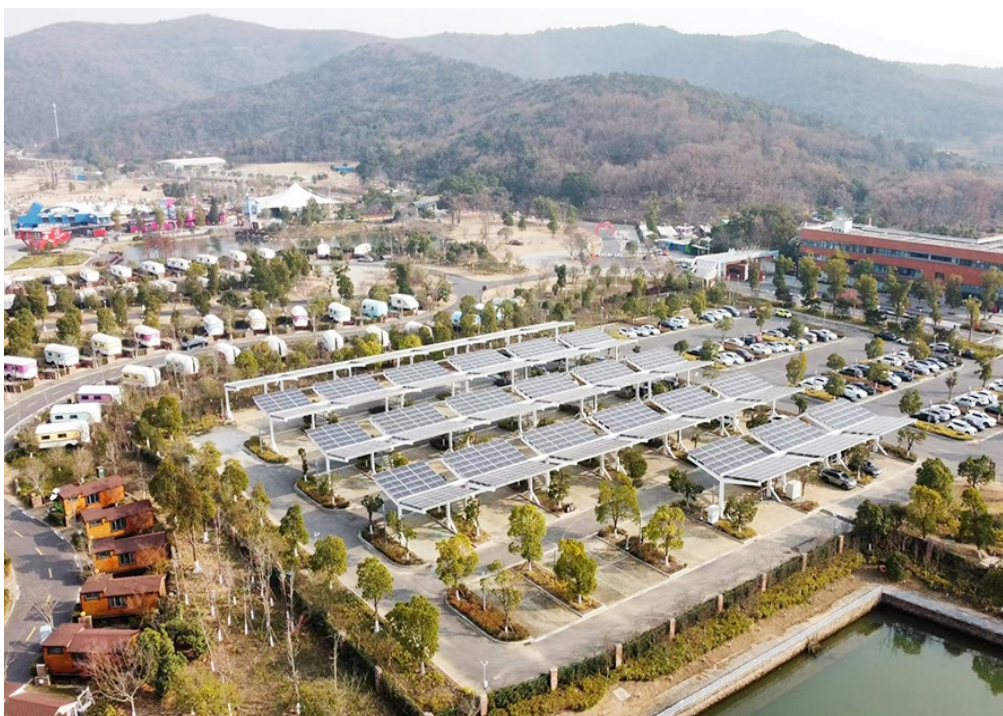
日前,太湖湾露营谷新增的“光储充”一体化停车场已开始运营(如图),建设约2400平方米屋顶光伏,采用“自发自用、余电上网”模式,配备48个充电桩,预计年发电量可达50万千瓦时,成为常州文旅板块最大的光储充一体化电站。 钱奎 摄
