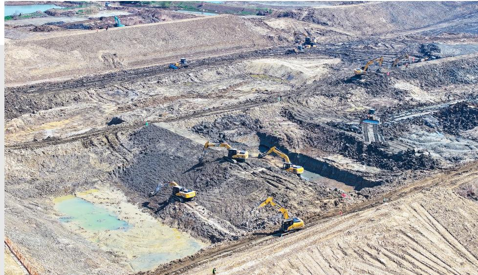
江苏省溧阳片区水环境综合治理和可持续发展试点（溧阳武进段一期）项目是省重大项目，其中，溧阳生态清淤（三期）水利工程项目总投资1.97亿元，规划用地约650亩。目前前期排泥场围堰正在加紧施工，计划4月初进行清淤施工，整体清淤及真空预压底泥固结施工计划年内完成。陆新 钱全 摄
